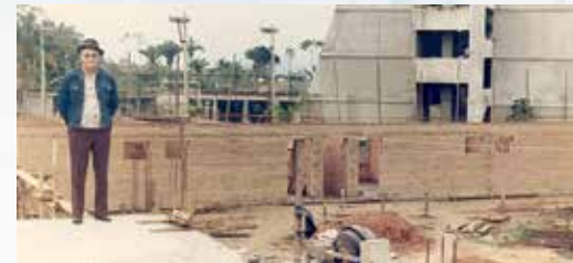
Construção da Colônia de Férias (02.05.82)
